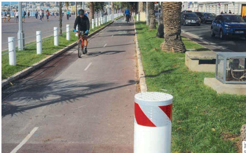
La sécurisation de la Promenade des Anglais fut l'un des gros chantiers de l'année écoulée.
