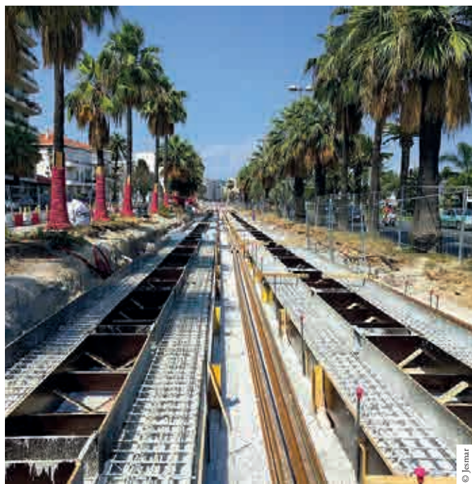
À Nice, les travaux du tramway ont soutenu l'activité.
