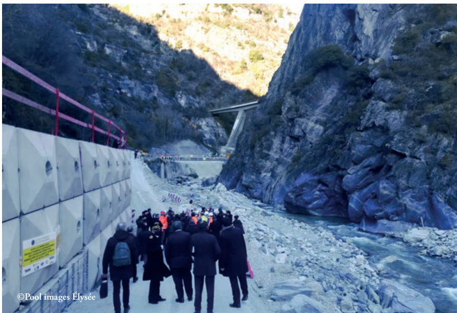
©Pool images Élysée Le Président a fait un arrêt sur la route de Tende pour constater l'état d'avancement des travaux.
