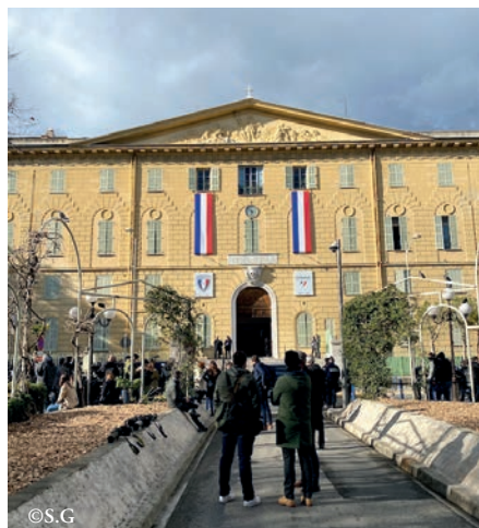
Les travaux du futur hôtel des polices devraient se terminer fin 2025.
