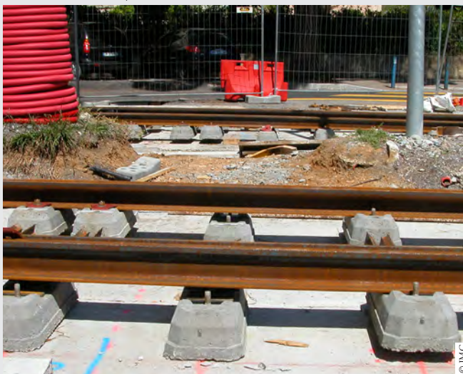
Nice-ouest : non, les rails du tramway ne resteront pas suspendus en l'air comme sur cette photo. Du béton sera coulé entre les traverses pour que la ligne 3 garde bien les pieds sur terre...
