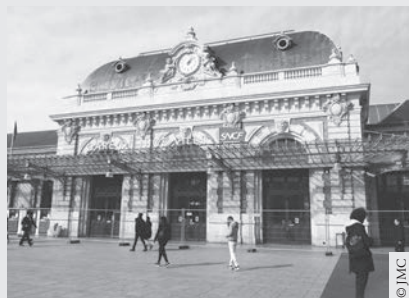
Allongement des quais, escaliers mécaniques, passerelle : la gare Thiers fait l'objet de gros travaux jusqu'à la fin 2017.
